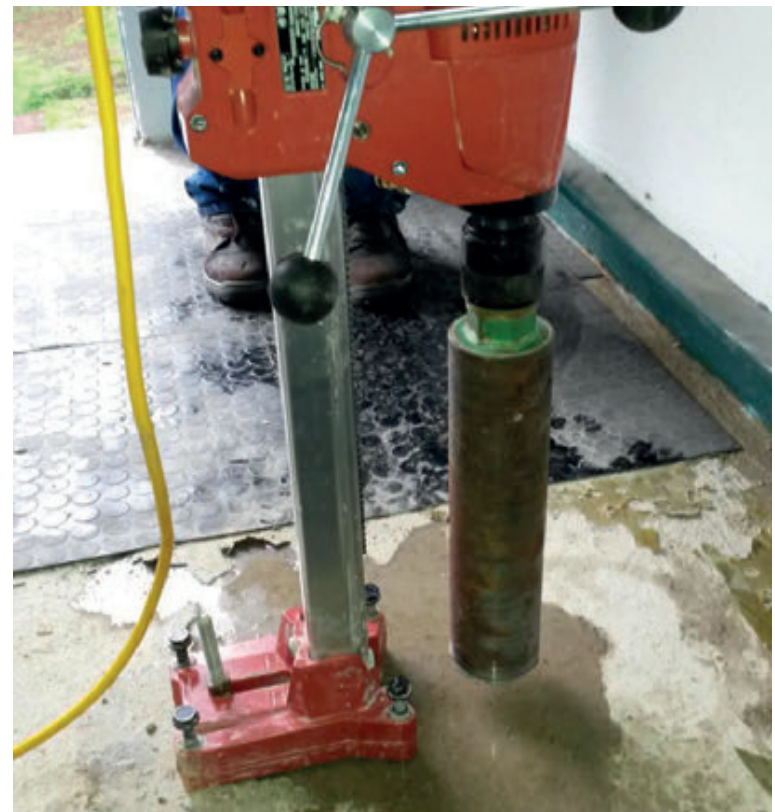
↑ Extracción de núcleo de concreto. SHUTTERSTOCK - THEERA DISAYARAT
